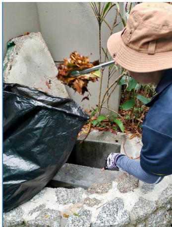
ภาพถ่ายที่ 2.2-13 การขุดลอกที่ระบายน้ำรอบโครงการ
